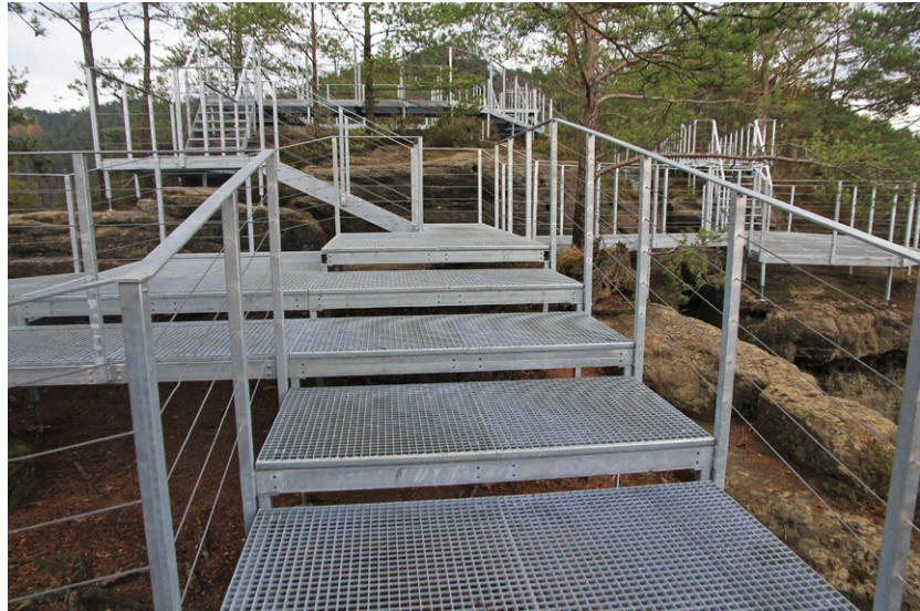
Bestens umsorgt und gut ausgebaut. Disneyland oder nicht? Auf der kleinen Felsenburg Falkenstein im Nationalpark Böhmisches Schweiz läuft der Besucher seit November 2017 inmitten von Geländern auf verzinkten Stahlgittern.
